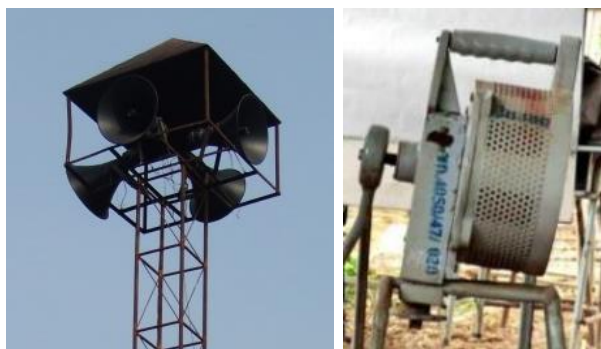
図2 屋外スピーカー(左)・手動サイレン(右)
